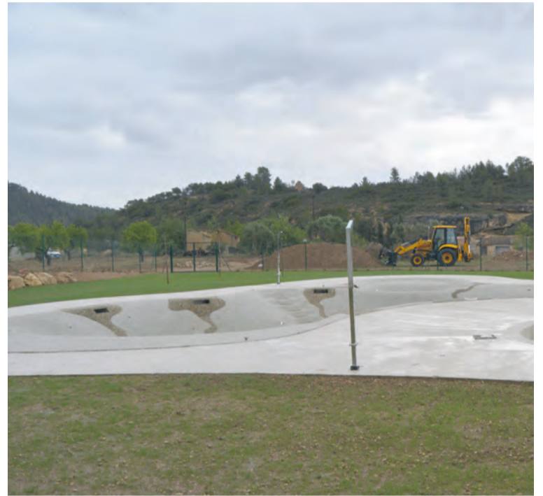
La piscina municipal es la primera parte de un proyecto mayor. M. Jiménez
